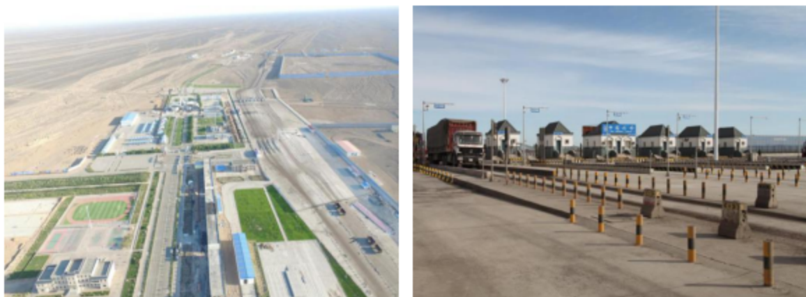
图 3、4 策克口岸通道
